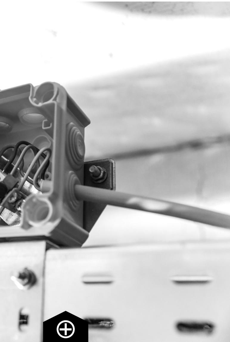
Zum Abzweigen und Verlängern der Kabel dienen Kabelabzweiggästen, die die Kabel auch vor allen äußeren Einflüssen wie Staub oder Wasser schützen. Hier wird die OBO FireBox direkt an der Rinne installiert. Alternativ ist auch eine Montage an Wand oder Decke möglich. Eine brandsichere Verbindung der Adern wird durch Keramikklammern sichergestellt.
