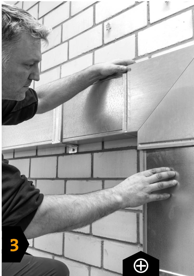
Beim Kanalsystem PYROLINE® Rapid lässt der Elektriker nach Installation der Leitungen den Deckel einfach einrasten– ohne den Einsatz von Schrauben oder Werkzeug. Verbinder sorgen für Rauchverschluss: die Verschlusskontur zwischen Deckel und Unterteil dichtet effektiv ab.
