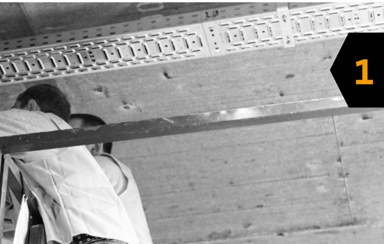
Der Installateur wählt das Material der Kabelrinnen stets entsprechend der vorhandenen Vorschriften. In unserem Straßentunnel erfolgt die Trassenmontage mit einem speziellen Tunnelbügel aus rostfreiem Stahl. Alternativ sind auch viele andere Montageausführungen erhältlich, z.B. mit Hängestielen und Auslegern.
