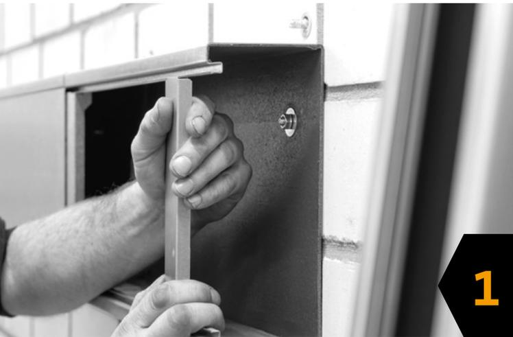
Der Installateur kann zwischen drei verschiedenen Abmessungen für verschiedene Kabelvolumina wählen. Die Kanäle werden in Längen von 2 Metern geliefert und eignen sich daher auch zur schnellen und einfachen Streckenmontage.
